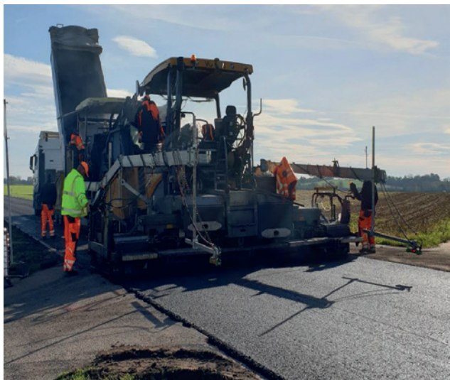
Obrázek 5: Porovnání pokládky standardní asfaltové směsi s teplotou 160 °C a nízkoteplotní asfaltové směsi s teplotou 140 °C (teplota vzduchu 5 °C)
