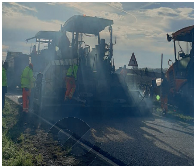
Obrázek 5: Porovnání pokládky standardní asfaltové směsi s teplotou 160 °C a nízkoteplotní asfaltové směsi s teplotou 140 °C (teplota vzduchu 5 °C)
