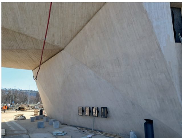
Obrázek 5: Pohled na líc opěry O1 – Hlubočepy
