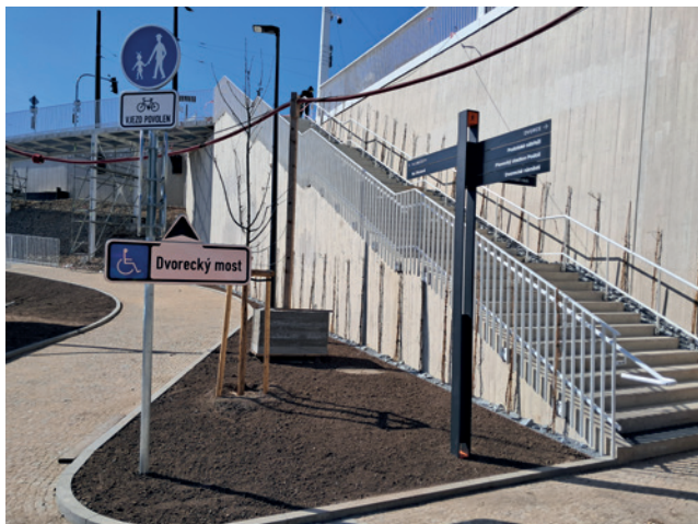
Obrázek 11: Jižní strana opěry O1 – Hlubočepy
