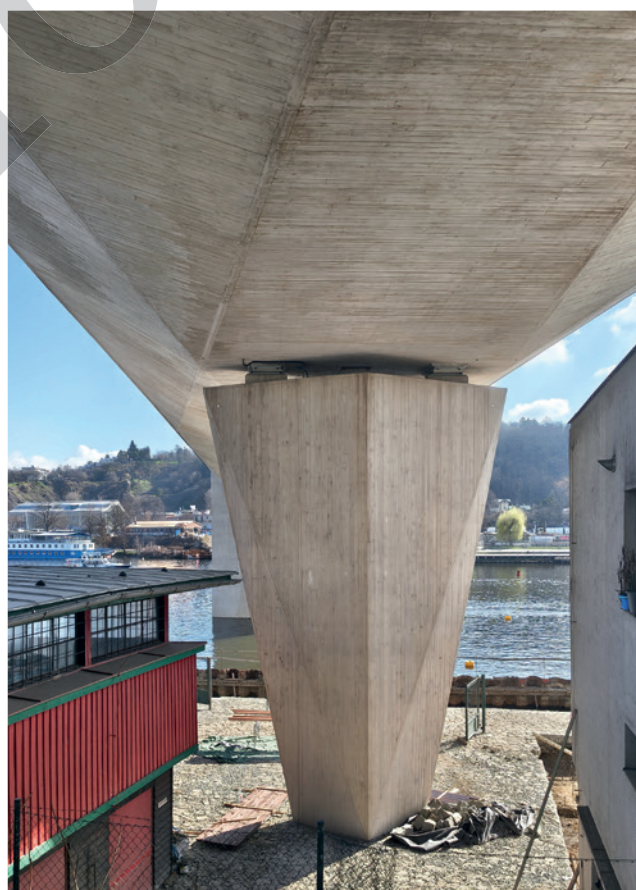
Obrázek 4: Pohled na pilíř P3 od Strakonické
