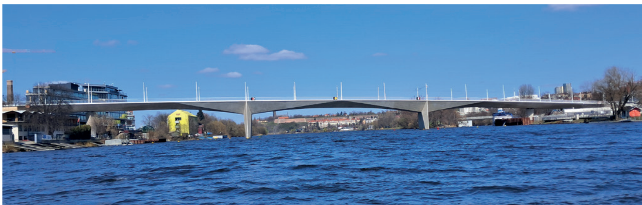
Obrázek 2: Současný pohled na most od jihu z koryta řeky Vltavy
