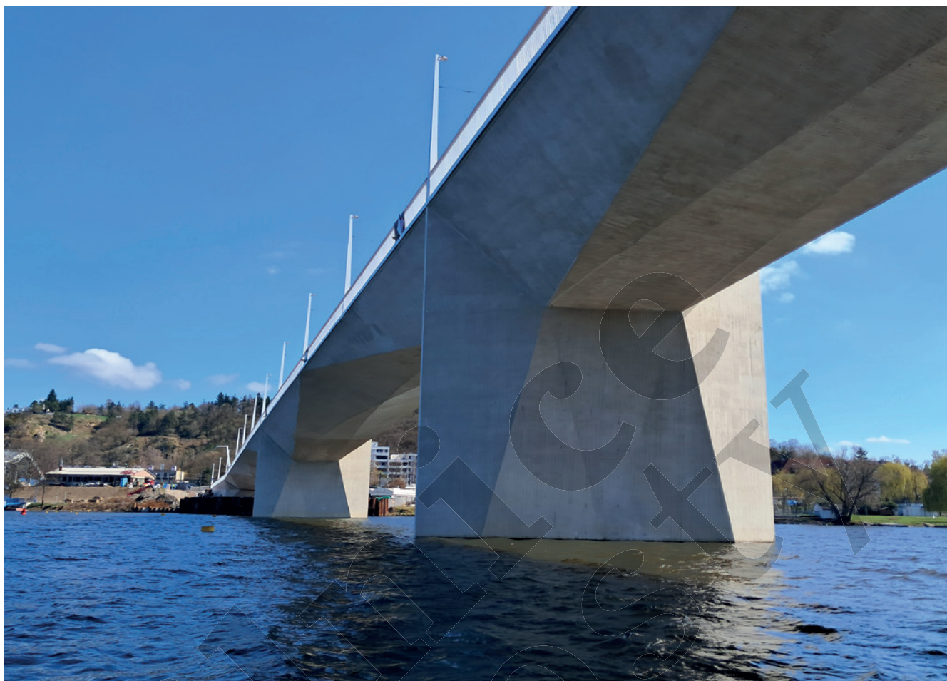
Obrázek 3: Pohled na pilíř P4 od levého břehu
