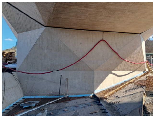
Obrázek 6: Pohled na líc opěry O7 – Podolí
