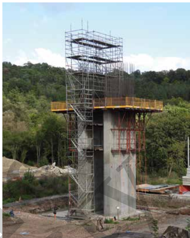
Obrázek 4: Výstavba pilíře P4
