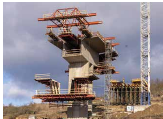
Obrázek 6: Instalace vozíku letmé betonáže na P3
