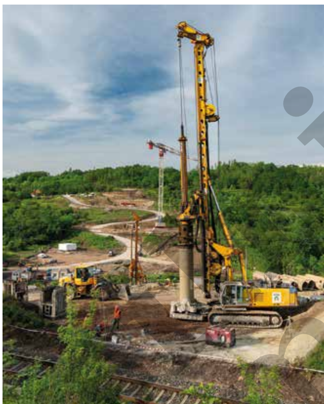
Obrázek 3: Vrtná souprava – zakládání pilíře P5
