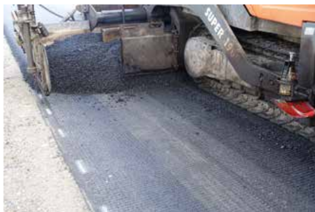
Obrázek 1: Vlevo – pohled na instalovanou samolepicí geomříž na povrchu vozovky, vpravo – detail pokládky asfaltové vrstvy na geomříž
