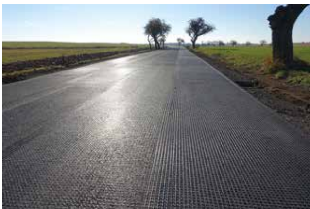
Obrázek 1: Vlevo – pohled na instalovanou samolepicí geomříž na povrchu vozovky, vpravo – detail pokládky asfaltové vrstvy na geomříž
